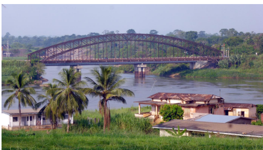
Pont métallique en arc sur le fleuve Sanaga
